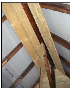
Bardage de toiture accessible aux chiroptères (Sources : Photo 1 : Thomas Frank, schémas 1 et 2 : Cerema Est)
